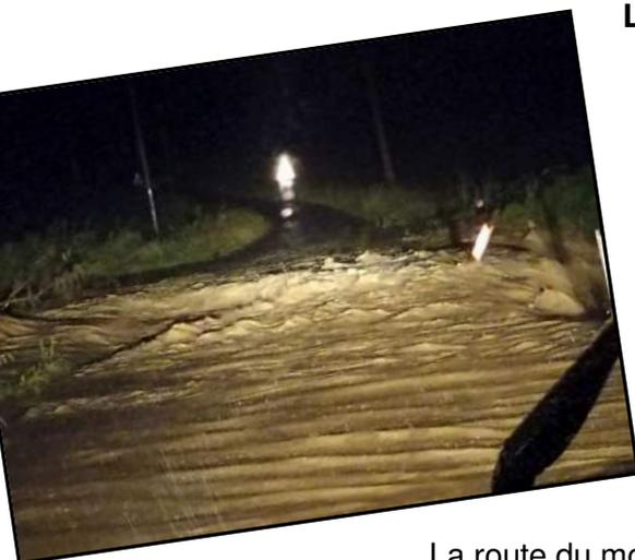
La route du moulin : Accélérée lors de son passage à travers un busage, l'eau a provoqué un glissement de terrain en bordure de la route. Cela a causé la rupture d'une canalisation d'eau potable qui dessert la maison Vidot.
